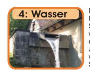
Das **Wasserkraftwerk** Brauerei Rheder deckt 1/3 des gesamten Strombedarfs der Brauerei ab. Es wurde 2011 modernisiert und erreicht je nach Wasserstand bis zu 38 kW Leistung. Jährlich werden so etwa 150.000 kWh Strom erzeugt.
