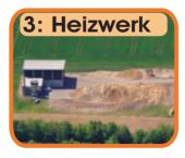
Das **Heizwerk** in Brakel ist ein Hackschnitzel-Heizwerk zur örtlichen Wärmeversorgung. Zwei Holzkessel mit je 1,2 MW Leistung liefern jährlich rund 6 Mio. kWh Wärme. Ca. 3.000 t Hackschnitzel werden jährlich zur Erzeugung benötigt. Die Wärme wird an fünf Abnehmer geliefert.
